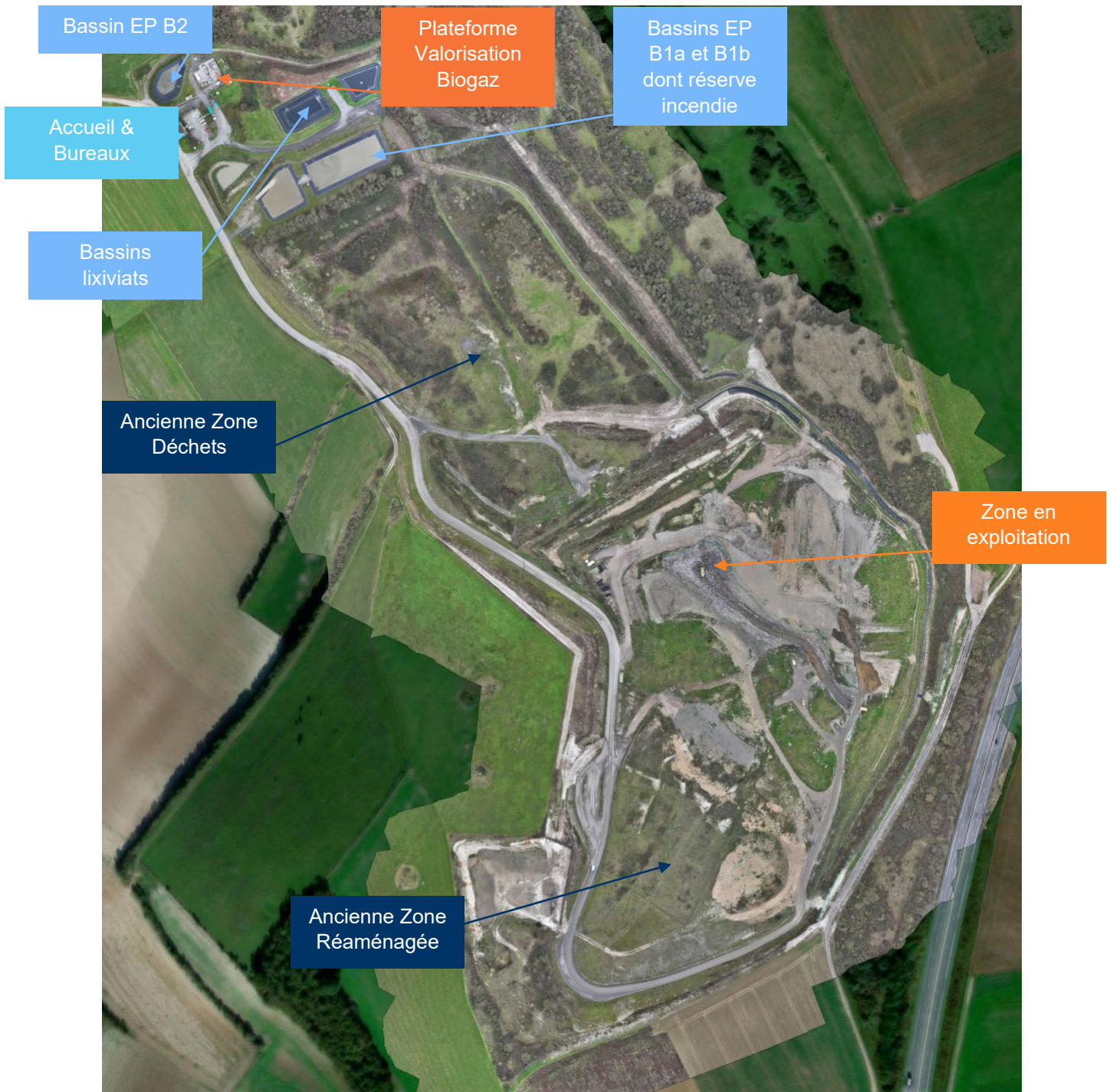
Figure 3 : Situation de l'ISDND – Photo aérienne – Décembre 2025
