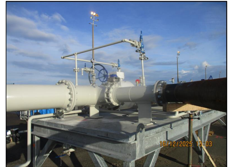
Mise en aérien de la gare de départ 16 pouces
