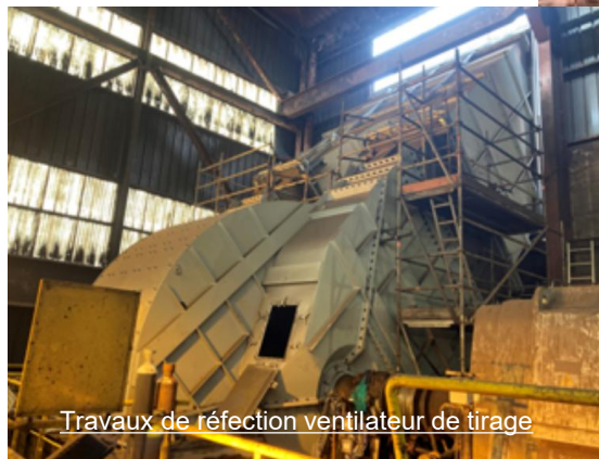
Travaux de réfection sur filtre
