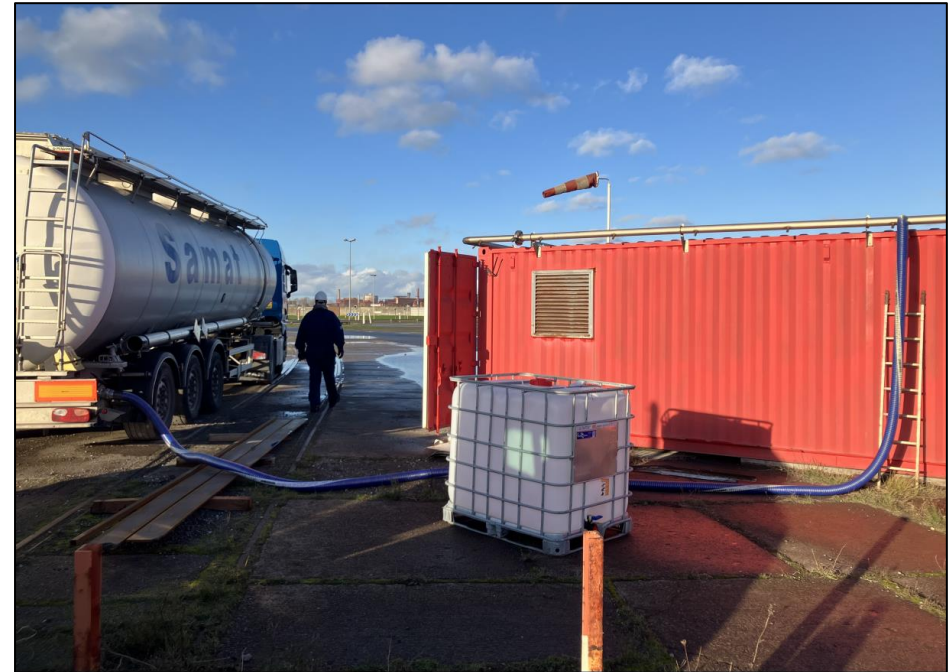
Remplacement de l'émulseur de la DCI de l'appontement
