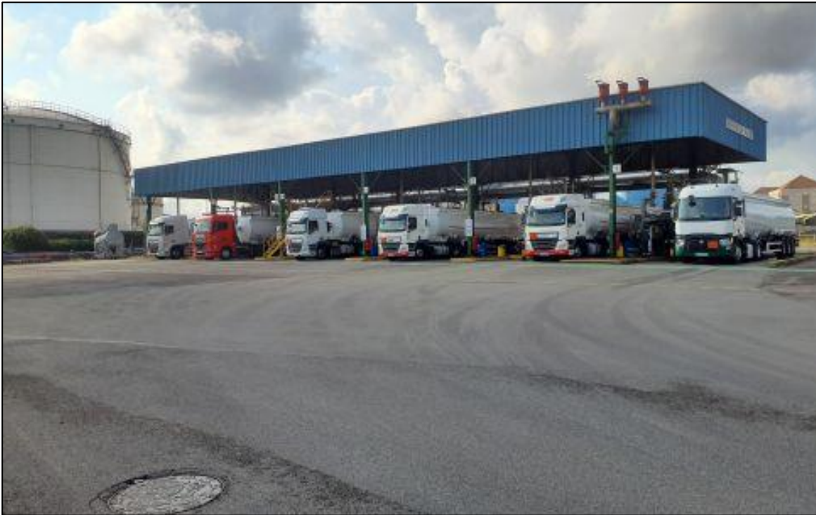
Nouveau poste de chargement source
