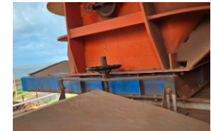
27/10 - ATAA - Contremaître Agglo - Pincement auriculaire G - Coincement par une guillotine d'extraction de silo
