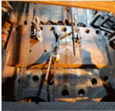
Remplacement du blindage percé
