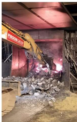
Mise en place d'une protection et ouverture du haut-fourneau
