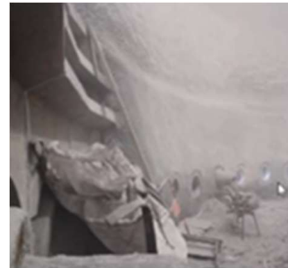
Remplacement des staves en fonte du rang 1
