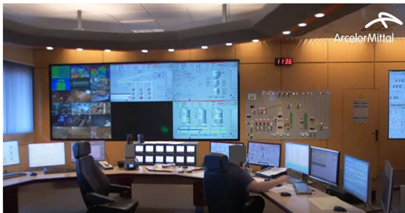
Salle de commande des hauts-fourneaux avec des ordinateurs puissants pour gérer des milliers de paramètres process
