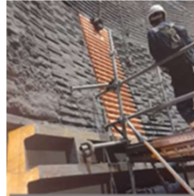
Remplacement des staves en cuivre du rang 5
