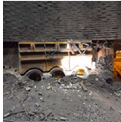
Remplacement des staves en fonte du rang 1
