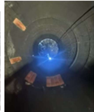
Remplacement des staves en cuivre du rang 5
