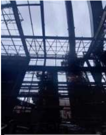
Dépose de la toiture
