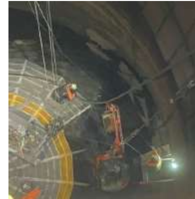
Mise en place d'une plateforme mobile pour changer les staves du rang 1
